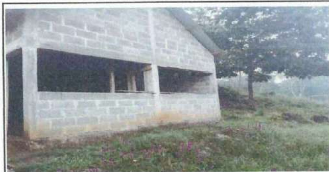
Foto 6: Muestra las 2 ventanas a colocarla.
