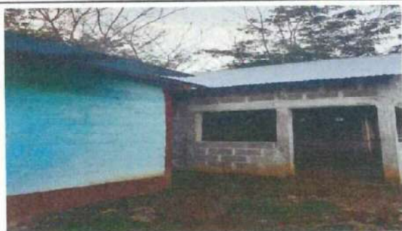
Foto 5: Muestra la puerta y ventana pequeña a colocarlo.
